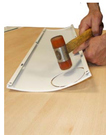
Fig. 32 - Ouvrir le trou (modèle Sfera 3 Plus)
