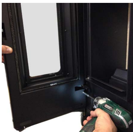
Fig. 73 - Desserrer la vis
