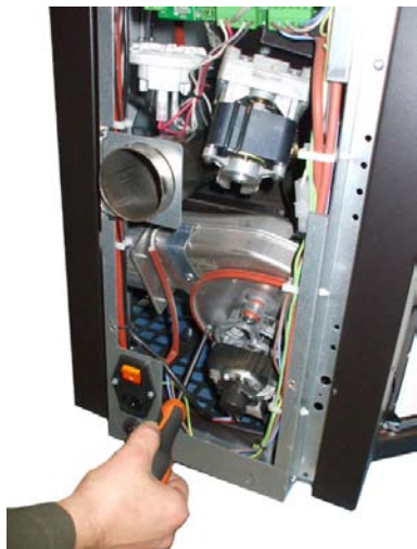
Fig. 86 - Nettoyage de l'aspirateur des fumées: phase 1
