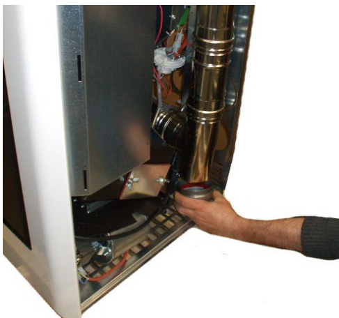
Fig. 84 - Nettoyage du collecteur des fumées
