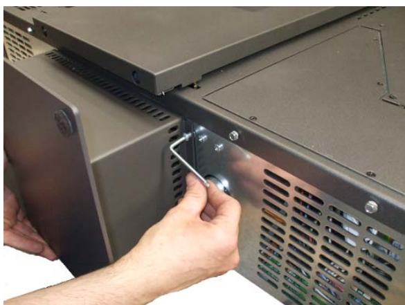
Fig. 14 - Assembler piédestal
