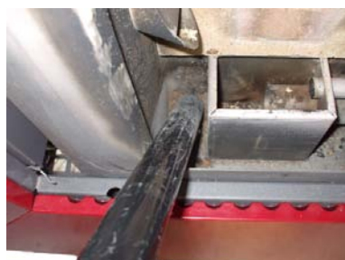
Fig. 29 - Nettoyage l'espace du tiroir à cendre
