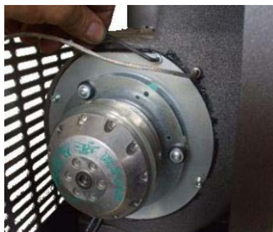
Fig. 35 - Nettoyage de l'aspirateur des fumées: phase 1
