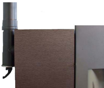
Fig. 34 - Nettoyage du conduit de fumée
