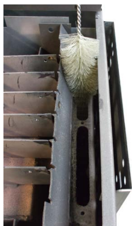
Fig. 41 - Nettoyage du canal
