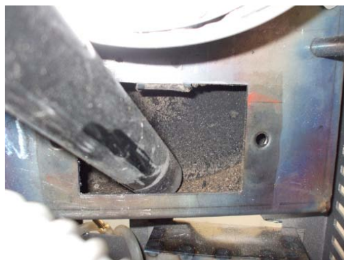
Fig. 33 - Nettoyage de la chambre des fumées
