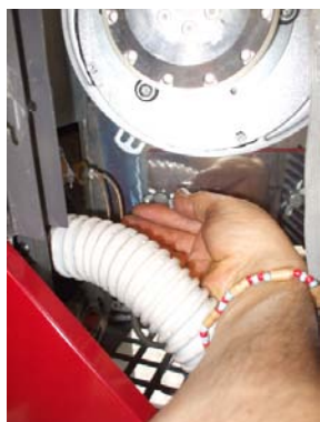
Fig. 32 - Chambre des fumées
