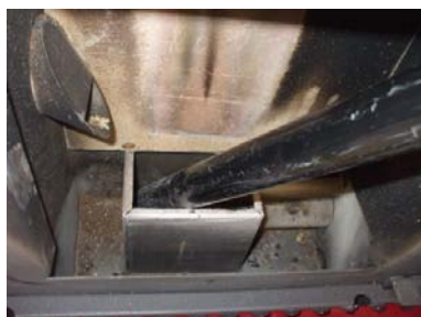
Fig. 28 - Nettoyage l'espace du brasero
