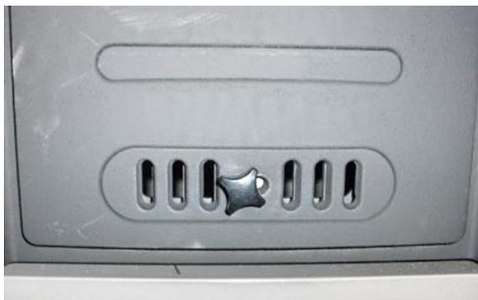
La chaudière possède un volet de réglage d'air secondaire sur la porte, en façade.
